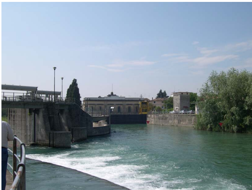
Opera di presa del canale della Vittoria vista da nord. Fonte: Archivio fotografico Consorzio di Bonifica Piave
